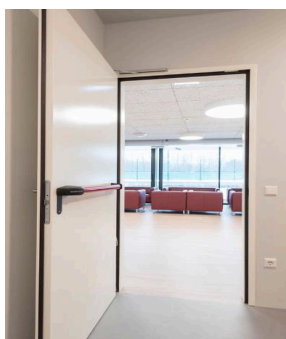
CERRADURA SEGURIDAD INSTALADA
